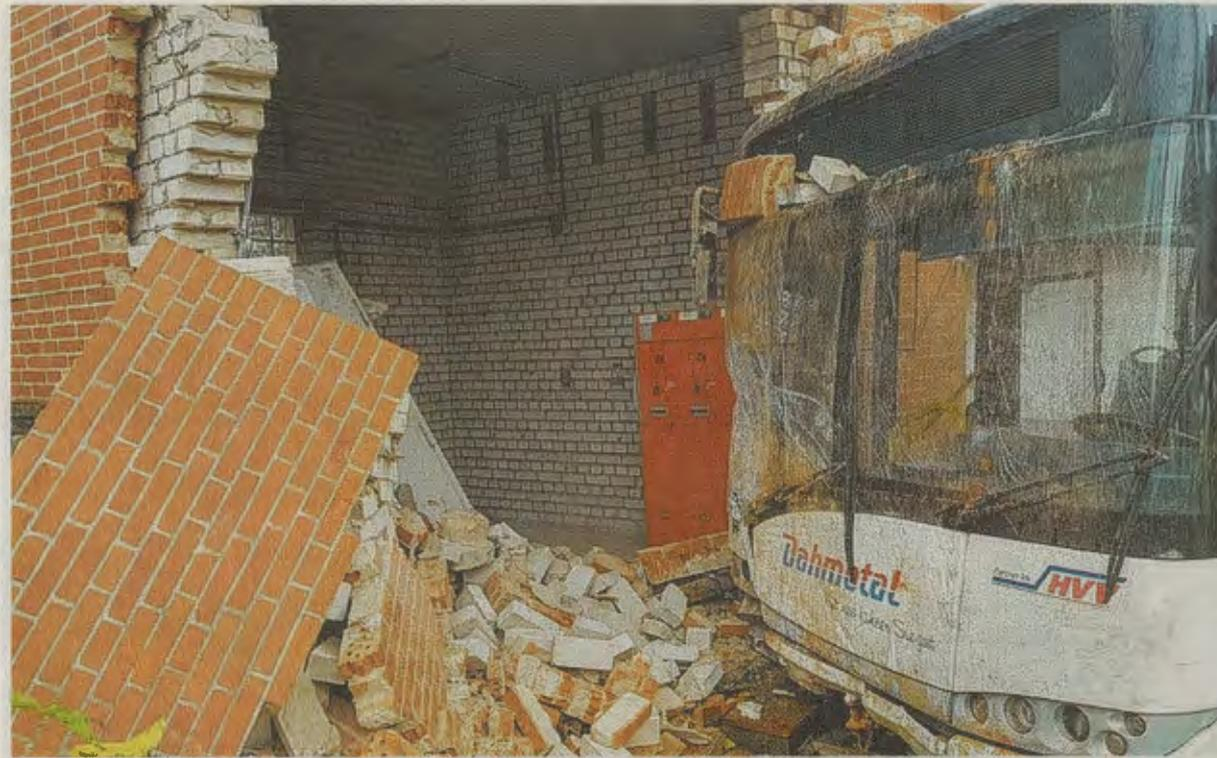
Die Ortsnetzstation aus den 50er Jahren wurde bei dem Unfall zerstört. Zum Glück bleibt der Bereich mit dem Trafobus, wo der Strom von elf Kilovolt auf Haushaltsstrom umgespannt wird, unbeschädigt. FOTO: HOLGER KRÖGER
